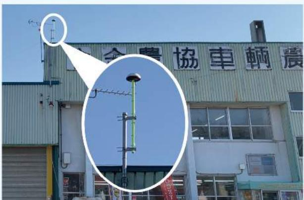
農協整備工場にRTK基地局のアンテナが設置され、開局しました。
