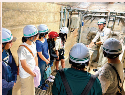
ダム堤防内点検通路で安全装置について説明を受ける様子
